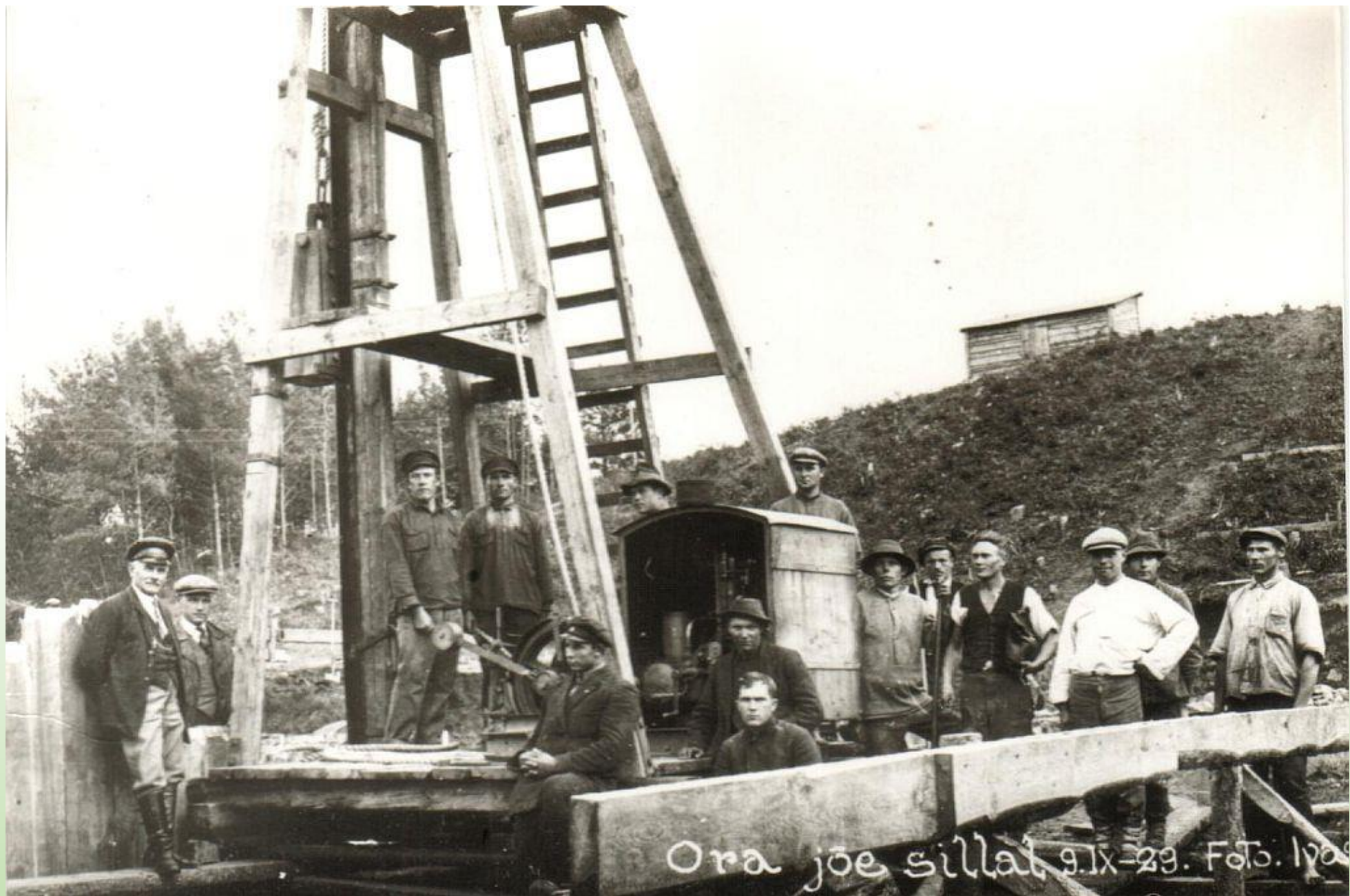
Tartu Petseri raudtee ehitus, jõutud on Orajõe silla ehituseni. Töölised rammimismasina juures 9.09. 1929. a. Foto: Ivask
